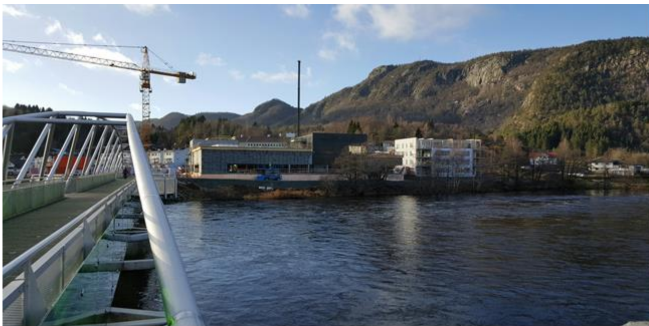
Den nye Svømmehallen under utbygging. Foto: Hartmann Runarsson
